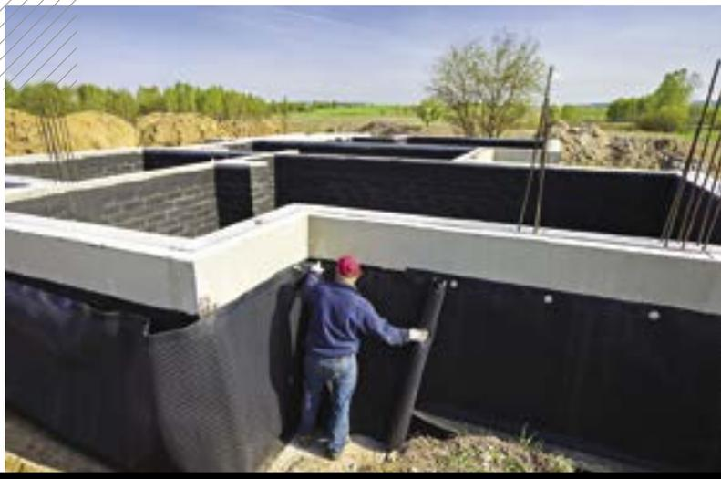
**Как показывает практика, чаще всего разрушение целостности гидроизоляции приходит при выполнении работ по обратной засыпке грунта. Для защиты от этого негативного воздействия применяются профилированные мембраны.**
