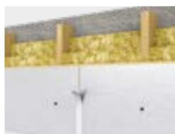
**в)** Основной крепеж термоплит LOGICPIR PROF Ф/Ф осуществляется через деревянные бруски, совпадающие со стойками каркаса.
