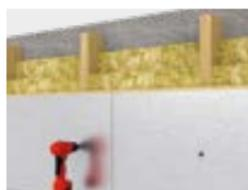
**б)** Для создания полностью паронепроницаемого барьера проклейте стыки термоплит алюминиевой самоклеящейся лентой. Применение LOGICPIR PROF Ф/Ф позволяет полностью отказаться от монтажа пароизоляционной пленки – фольга, служащая обкладкой термоплит, препятствует проникновению увлажненного воздуха внутрь кровли и дальнейшей конденсации влаги внутри конструкции.
