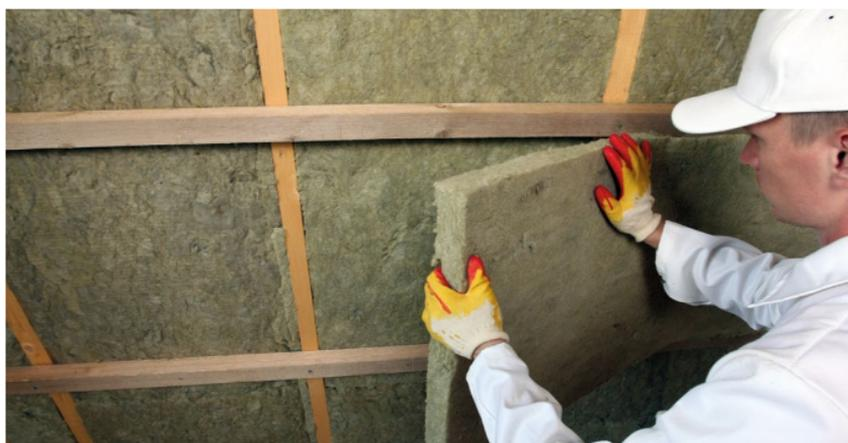
Рис. 4. Укладка второго слоя теплоизоляции
