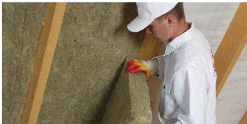
Рис. 3. Монтаж теплоизоляции враспор между стропилами
