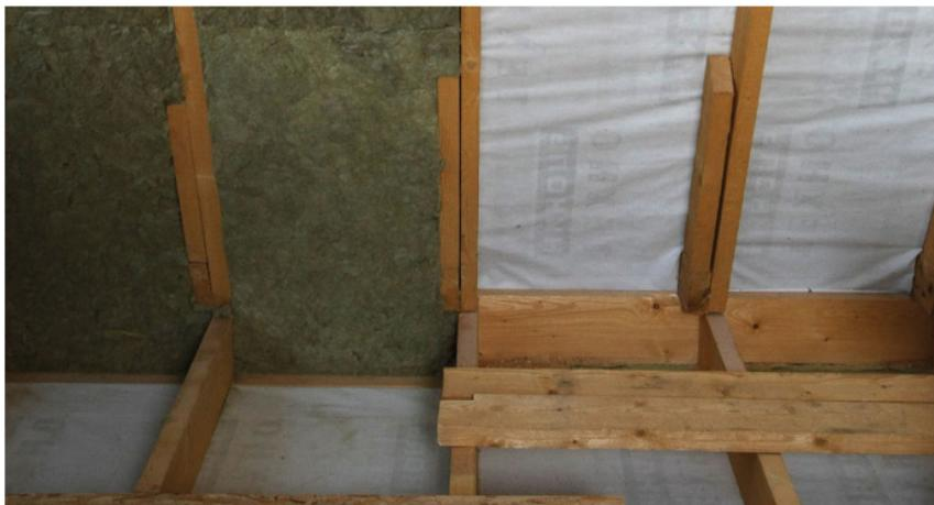
Рис. 2. Подготовленная система для дальнейшего монтажа теплоизоляции
