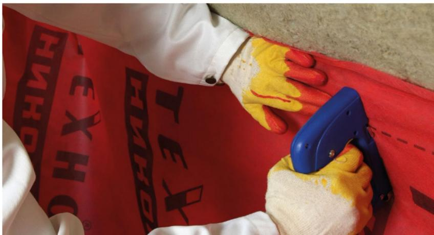
Рис. 5. Укладка и фиксация пароизоляционной пленки
