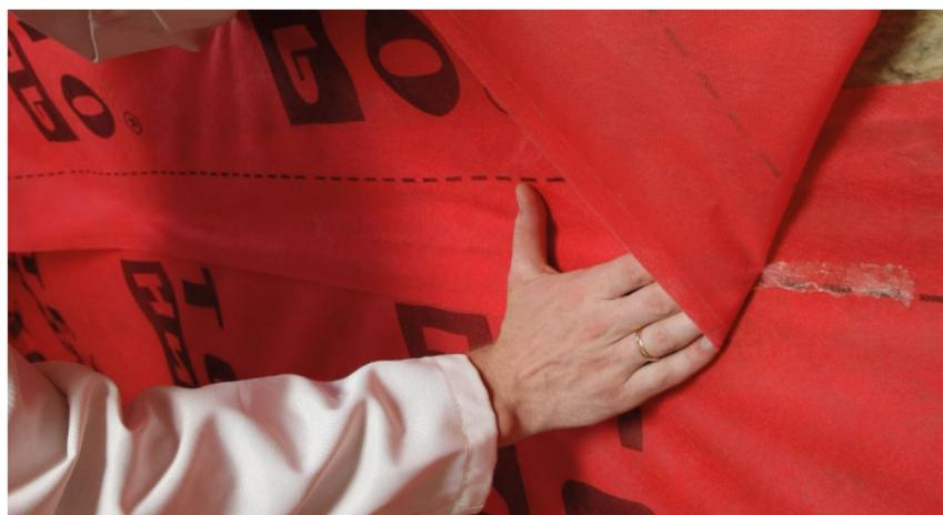
Рис. 6. Проклейка стыков пароизоляционной пленки
