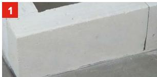
Укладка первого ряда блоков на клей-пену возможна на идеально ровное основание. В противном случае кладка первого ряда выполняется при помощи традиционного раствора.
