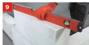
В течение 3-х минут после выпуска клей-пены произвести укладку блока и его корректировку при помощи киянки и уровня.
