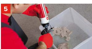
Отвернуть регулировочный винт пистолета, нажать на спусковой крючок, стравить некоторое количество клей-пены в контейнер.
