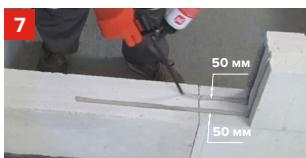
Нанести клей-пену параллельными полосами шириной 20–30 мм на горизонтальные и вертикальные грани блока. При нанесении клей-пены сделать отступ в 50 мм от края блока.
