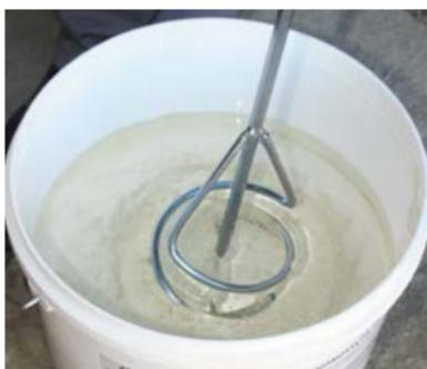
Перед нанесением тщательно перемешайте герметик низкооборотистой дрелью со специальной насадкой в течении 10–12 минут.
