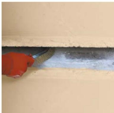
Грани панелей и внутренние поверхности стыка очищают от наплывов раствора, пыли и грязи, используя металлическую щетку, ветошь, губку или любой обтирочный материал.
