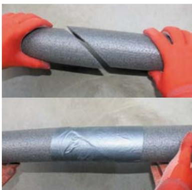
Прокладки соединяют «на ус» при помощи клейкой полиэтиленовой или матерчатой изоляционной ленты.
