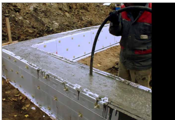
Виброуплотнение бетона с помощью глубинного вибратора.
