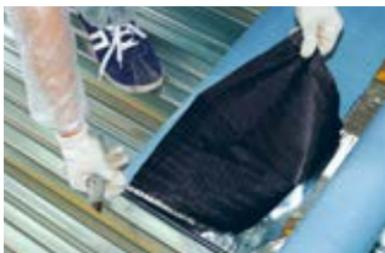
С помощью кровельного ножа надрежьте с нижней стороны материала защитную пленку на расстоянии 30–40 см от края рулона.
