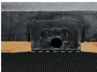
Установите наклонные бортики (ТЕХНОРУФ ГАЛТЕЛЬ) к парапетной воронке на горячую мастику. Создайте плавный переход от наклонной поверхности бортика к вертикальной поверхности дополнительного слоя.
