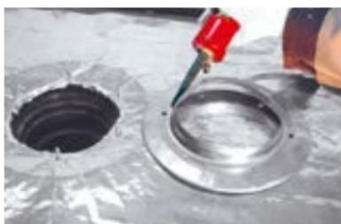
Для повышения герметичности соединения фланца с пароизоляционным материалом нанесите мастику герметизирующую ТЕХНОНИКОЛЬ № 71.
