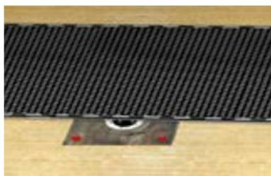
Расположите первое полотнище кровельного материала Техноэласт ФИКС таким образом, чтобы боковая кромка проходила через ось водоприемной воронки.
