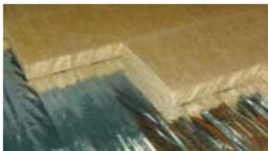
Укладку теплоизоляционных плит по профлисту производите так, чтобы длинная сторона плиты была перпендикулярно гофрам профнастила.
