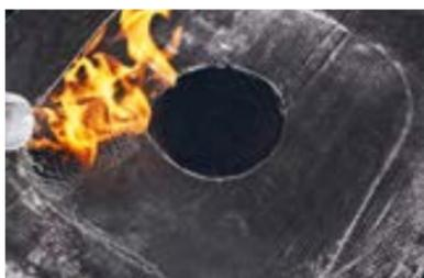
Разогрейте пламенем горелки область слоя усиления, на которую будет установлена воронка.
