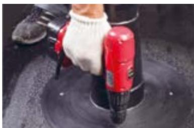
Закрепите кровельный аэратор в основании, используя минимум 4 крепежных элемента. В качестве крепежных элементов применяйте остроконечные саморезы ТЕХНОНИКОЛЬ EDS-S 4,8 мм с полиамидной гильзой.
