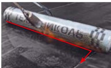
При наплавлении смежных рулонов траектория движения горелки должна описывать букву «Г», с дополнительным прогревом той области материала, которая идет внахлест (размеры нахлестов указаны ниже).
