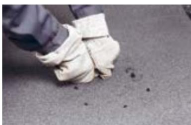
Пока не остыл материал, продавите болтовые соединения воронки через материал Техноэласт ЭКП.
