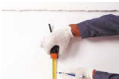
Нанесите разметку, чтобы огрунтовать всю площадь заведения материала на вертикальную поверхность (стена, парапет).
