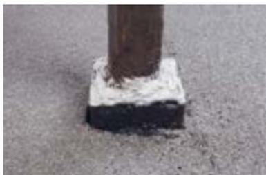
Заполните пространство между трубой и стенками стакана герметиком двухкомпонентным полиуретановым ТЕХНОНИКОЛЬ № 2К.
