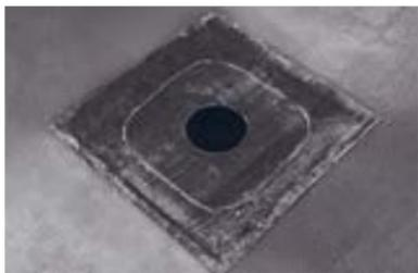
В установленном слое усиления прорежьте круглое отверстие под трубу водоприемной воронки и очертите контур юбки воронки.
