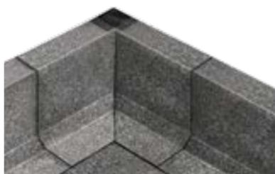
Наплавьте дополнительный верхний гидроизоляционный слой на всю плоскость парапета с другой стороны угла парапета
