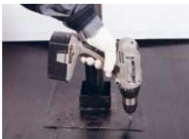
Закрепите металлический стакан в основание, используя минимум 4 крепежных элемента. В качестве крепежных элементов применяйте остроконечные саморезы ТЕХНОНИКОЛЬ EDS-S 4,8 мм с полиамидной гильзой.
