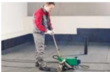
После устройства всех рулонов к сборной полосе сварите все торцевые швы с помощью выбранного оборудования (см. п. 4.4).
