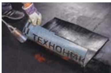
Для качественного наплавления материала необходимо добиться небольшого валика битумно-полимерного вяжущего в месте соприкосновения материала с поверхностью.
