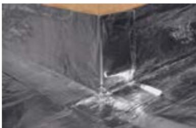
При укладке материала на горизонтальной части заведите материал сразу и на вертикальную поверхность, где это возможно. Материал должен заводиться на вертикальную часть выше теплоизоляционного слоя на 25 мм.
