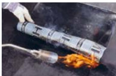
Наплавьте слой усиления в область местного понижения водоприемной воронки (согласно проекту) к листу плоского шифера (см. п. 2.5.3). Нагрев производите плавными движениями горелки, обеспечьте равномерный нагрев материала и поверхности основания.
