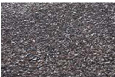
Визуально проверяют качество защитного слоя. Защитный слой должен равномерно распределяться по всей поверхности кровли.
