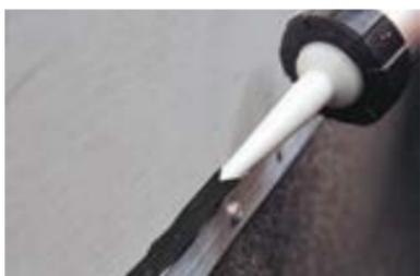
Зазор между стеной и отгибом краевой рейки заполните Мاستикой герметизирующей ТЕХНОНИКОЛЬ № 71.
