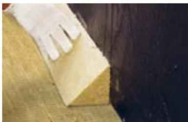
В местах примыкания к вертикальным конструкциям установите наклонные бортики (ТЕХНОРУФ ГАЛТЕЛЬ).
