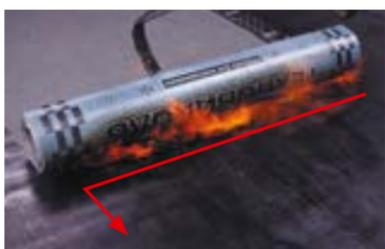
При наплавлении смежных рулонов траектория движения горелки должна описывать букву «Г», с дополнительным прогревом той области материала, которая идет внахлест.
