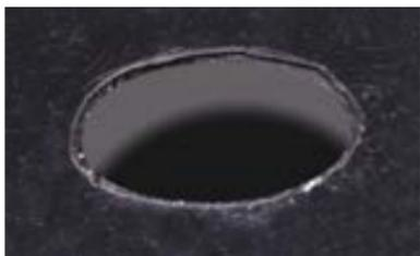
Прорежьте круглое отверстие в месте установки аэратора до уклонообразующего слоя из засыпного утеплителя. Диаметр отверстия должен быть равен внутреннему диаметру трубы аэратора.
