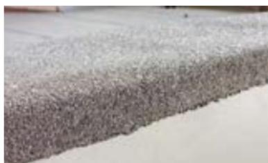
Завершите наплавление, приплавив нижнюю часть рулона с заведением на горизонтальный участок и на фасадную часть парапета на 50 мм.
