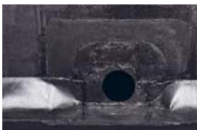
Наплавьте полосы слоя усиления на переходной бортик (см. п. 5.1.1 «Установка дополнительных слоев усиления в местах примыкания с вертикальными конструкциями»).
