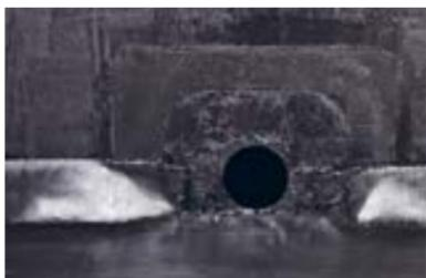
Наплавьте нижний слой (см. п. 5.2.1 «Наплавление нижнего слоя»). Материал подведите к наклонному бортику и к парапетной воронке.
