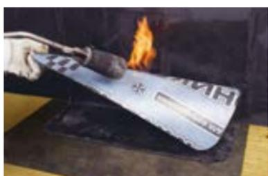
Вырежьте из материала Техноэласт ЭПП или Унифлекс Экспресс ЭМП слой усиления и наплавьте в область местного понижения водоприемной воронки. Слой усиления должен быть на 100 мм больше фланца парапетной воронки с каждой стороны.
