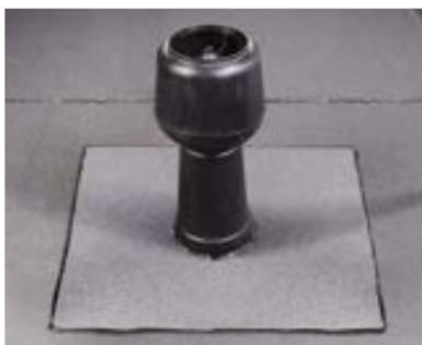
Подготовьте и наплавьте слой усиления. Слой усиления должен перекрывать фланец аэратора на 150 мм.
