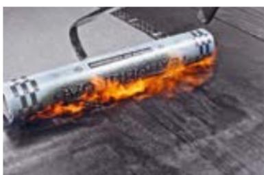
Для качественного наплавления материала на основание необходимо добиться небольшого валика битумно-полимерного вяжущего в месте соприкосновения материала с поверхностью.
