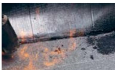
Наплавьте дополнительный верхний слой из материала Техноэласт ЭКП на вертикальную поверхность (см. п. 4.5).
