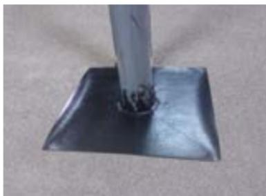
Прорежьте в центре квадрата окружность, диаметром равным диаметром трубы, таким образом, чтобы образовавшиеся зубчики заводились на вертикальную поверхность трубы.
