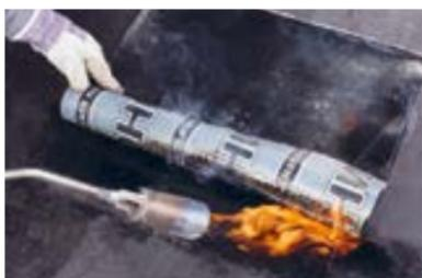
Установите дополнительный слой усиления в область местного понижения водоприемной воронки (согласно проекту) в соответствии с пунктом 5.1.2.
