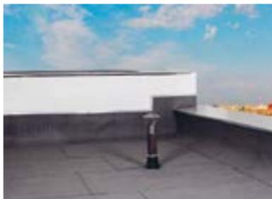
При приемке кровельного ковра из битумных материалов первым делом визуально контролируется состояние поверхности кровли на отсутствие порезов, прожогов, обнажения основы, а также наличие вздутий (пузырей), волн, застойных зон.
