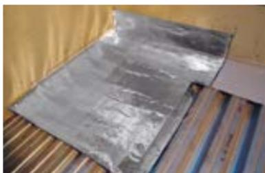
При подведении материала к вертикальной конструкции приклейте материал сразу на вертикальную поверхность. Материал заводится выше теплоизоляционного слоя на 25 мм.
