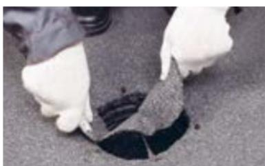
Прорежьте кровельный ковер по диаметру трубы водоприемной воронки.
