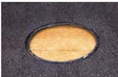
Прорежьте круглое отверстие в месте установки аэратора.
