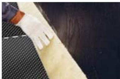
В местах примыкания к вертикальным конструкциям установите наклонные бортики (ТЕХНОРУФ ГАЛТЕЛЬ) на предварительно разогретый пламенем горелки материал.
