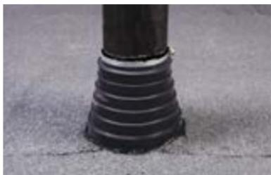
Установите обжимной хомут на уплотнитель и плотно затяните.
