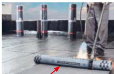
При наплавлении кровельного материала раскатывайте рулон «на себя».
