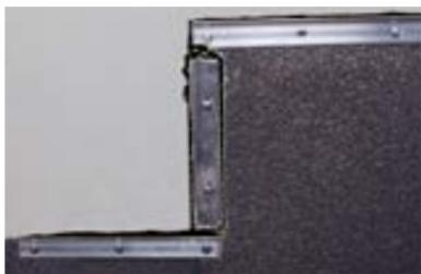
При наличии вертикальных переходов, расположите краевую рейку вертикально. Между смежными элементами крепления оставляйте зазор 5–10 мм. Мاستику герметизирующую ТЕХНОНИКОЛЬ № 71 нанесите с двух сторон вертикальной рейки.
