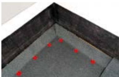
Подведите рулон Техноэласт СОЛО РП1 к вертикальной конструкции и заведите материал на наклонную плоскость бортика.
