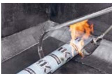
Наплавьте нижний слой (см. п. 5.2.1 «Наплавление нижнего слоя»). Материал подведите вплотную к наклонному бортику без заведения на галтель.
