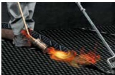
Для качественного наплавления материала необходимо добиться равномерного вытека битумно-полимерного вяжущего из-под кромки материала.
