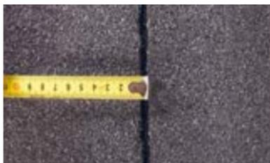
Признаком хорошего, правильного прогрева материала является вытекание битумно-полимерного вяжущего из-под боковой кромки материала от 10 мм до 25 мм.
