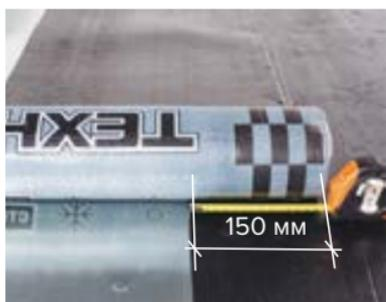
Наплавьте слой усиления из материала Техноэласт ЭПП. Слой усиления должен перекрывать карнизный свес на 150 мм.
