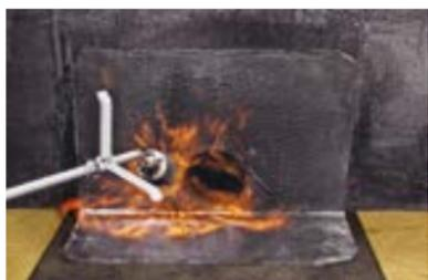
В установленном слое усиления прорежьте круглое отверстие под трубу водоприемной воронки.
