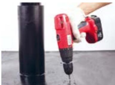
Закрепите металлический стакан в основании, используя минимум 4 крепежных элемента.
