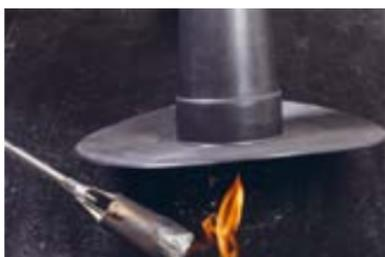
Разогрейте пламенем горелки область материала, на которую будет установлена установлен аэратор.
