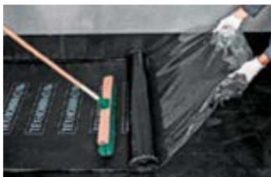
Укладку материала осуществляют два кровельщика. Один рабочий вытягивает антиадгезионную пленку на себя, разматывая рулон. Второй рабочий приглаживает материал при помощи щетки, выдавливая воздух из-под материала для обеспечения качественной приклейки к основанию.
