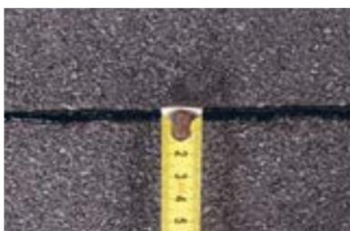
Основными критериями сварного шва являются — равномерный вытек битумного вяжущего не более 25 мм. Рекомендуется выполнять вытек 10–25 мм.
