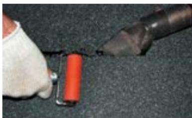
При прокатывании силиконовым роликом следите за вытеком битумного вяжущего.
