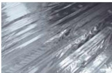
Приклейте пароизоляционную мембрану по всей площади несущего основания, в соответствии с п. 2.2.2. раздел «Укладка пароизоляции на общей плоскости».
