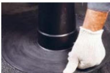
Установите аэратор и вдавите юбку в разогретый материал. Следите за равномерным вытеком битумно-полимерного вяжущего из-под фланца аэратора. Вытек обеспечит полную герметичность соединения.
