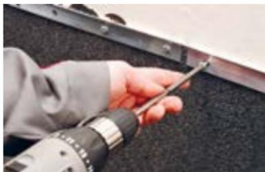
Наплавленный на вертикальную поверхность материал закрепите краевой рейкой при помощи остроконечных саморезов ТЕХНОНИКОЛЬ EDS-S 4,8 мм с полиамидной гильзой.
