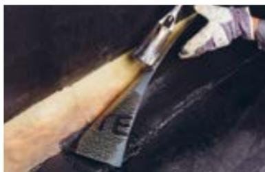
Для качественного наплавления материала на основание необходимо добиться небольшого валика битумно-полимерного вяжущего в месте соприкосновения материала с поверхностью.
