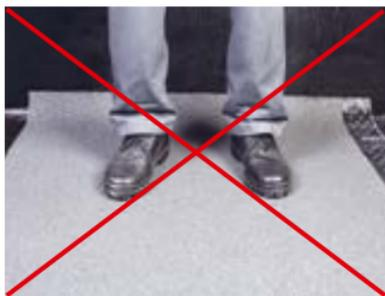
**ВАЖНО!** Запрещается ходить по неостывшему материалу!!! Посыпка утапливается в слой битумного вяжущего и на поверхности будут оставаться следы или участки с отслоившимся верхним слоем материала, что приведёт к ухудшению внешнего вида, ускоренному старению под воздействием солнечного излучения или механическому повреждению кровли.
