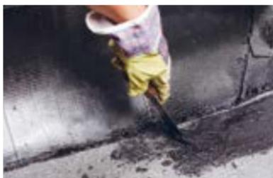
Для обеспечения нахлеста с дополнительным верхним слоем, разогрейте материал и втопите посыпку.
