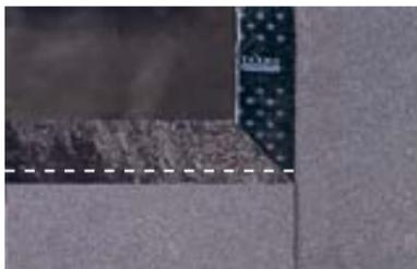
Торцевые нахлесты соседних полотнищ кровельного материала Техноэласт ЭКП должны быть смещены относительно друг друга не менее чем на 500 мм:
