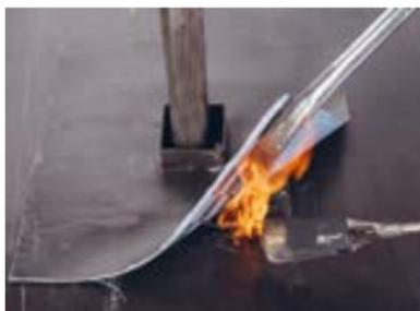
Установите и наплавьте дополнительный слой усиления. Следите за вытеком битума из-под кромки материала.
