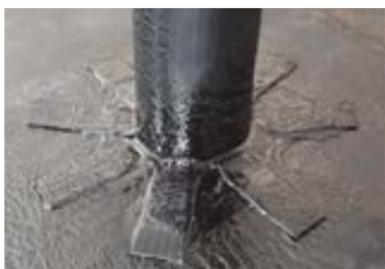
Наплавьте нижний оклад, таким образом чтобы лепестки нижнего оклада были смещены относительно зубчиков, заведенных на вертикальную поверхность трубы.
