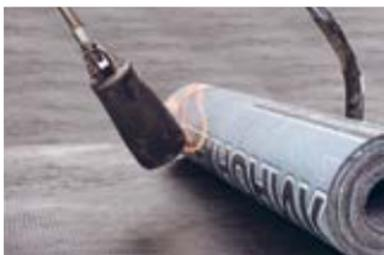
Наплавьте верхний гидроизоляционный слой Техноэласт ЭКП (см. п. 5.2.3 «Наплавление верхнего слоя»).
