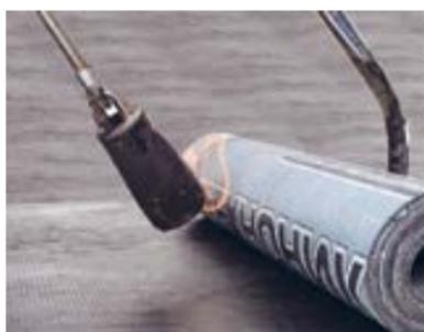
Наплавьте верхний гидроизоляционный слой Техноэласт ЭКП (см. п. 5.2.3 «Наплавление верхнего слоя»).
