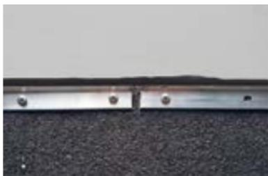
Между смежными элементами крепления оставляйте температурный зазор 5–10 мм.
