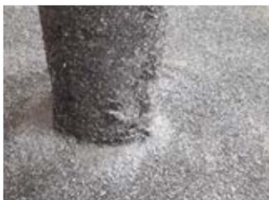
Уложите верхний слой на горизонтальной поверхности (см. п. 5.2.3 «Наплавление верхнего слоя»)
