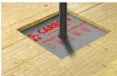
В области трубы, замените утеплитель из каменной ваты ТЕХНОРУФ на экструзионный пенополистирол ТЕХНОНИКОЛЬ CARBON PROF (далее по тексту XPS).
