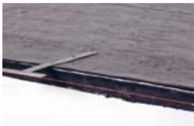
Установите и закрепите Т-образные кровельные костыли с шагом не более 700 мм.
