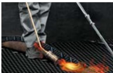
Сварите торцевой нахлест с помощью выбранного оборудования (см. п. 4.1).
