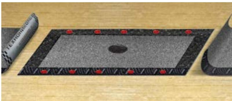
**ВАЖНО!** Во избежание противошовки соблюдайте правильный нахлест торцевого шва. Вода должна стекать со шва в сторону водоприемной воронки.
