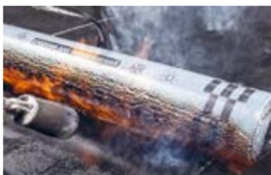
Деформация рисунка свидетельствует о правильном разогреве битумно-полимерного вяжущего с нижней стороны рулонного материала.
