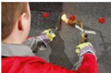
Для качественного наплавления по крупнозернистой посыпке произведите ее удаление из зоны сварки.
