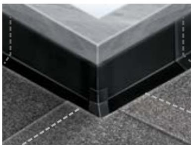
Наплавьте заплатку на угловое сопряжение с переходным бортиком.
