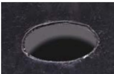
**ВАЖНО!** В случае устройства кровли по теплоизоляционным плитам PIR, прорежьте отверстие до пароизоляции.
