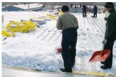
Очистите поверхность профлиста на рабочей захватке от пыли, строительного мусора, снега, льда, стружки, масла.
