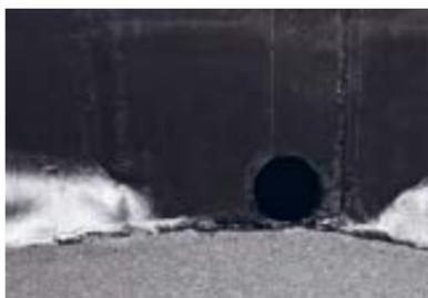
Наплавьте верхний слой из материала Техноэласт ЭКП (см. п. 5.2.3 «Наплавление верхнего слоя»).
