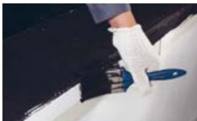
Перед устройством основания из сборной стяжки, огрунтуйте листы сборной стяжки с двух сторон Праймером битумным ТЕХНОНИКОЛЬ № 01.
