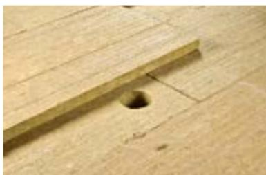
При устройстве теплоизоляции из двух и более слоев плитного утеплителя швы между плитами располагайте «вразбежку», обеспечивая плотное прилегание плит друг к другу.
