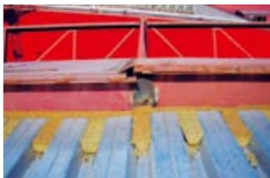
В местах деформационных швов, в примыканиях профлиста к стенам, вентиляционным шахтам, фонарям, выходам на кровлю заполните пустоты гофр профнастила минераловатными материалами с классом горючести НГ.
