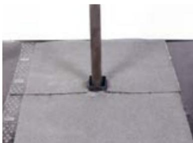
Наплавьте верхний слой кровельного материала (см. п. 5.2.3 «Наплавление верхнего слоя»).
