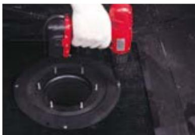
Закрепите водоприемную воронку к основанию, используя минимум 4 крепежных элемента.
