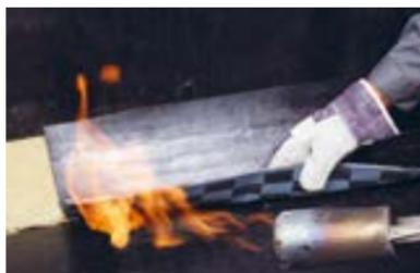
Наплавьте полосы слоя усиления из материала на наклонный бортик.
