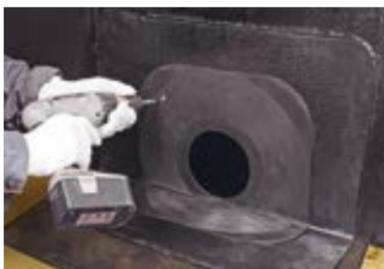
Закрепите водоприемную воронку к основанию, используя минимум 6 крепежных элементов (4 крепежа на вертикальной поверхности, 2 крепежа на горизонтальном основании). В качестве крепежных элементов применяйте остроконечные саморезы ТЕХНОНИКОЛЬ EDS-S 4,8 мм с полиамидной гильзой.
