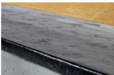
Наплавьте на листы АЦЛ (ЦСП) слой усиления из материала Техноэласт ЭПП.
