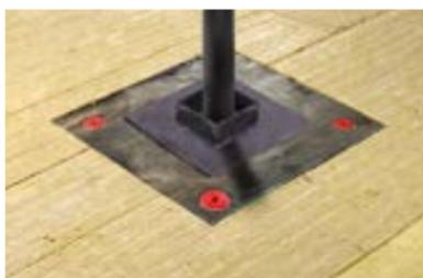
Установите стакан и вдавите фланец в разогретый материал. Следите за равномерным вытеком битумно-полимерного вяжущего из-под фланца стакана. Вытек обеспечит полную герметичность соединения.
