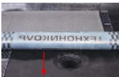
Наплавьте верхний слой из материала Техноэласт ЭКП (см. п. 5.2.3 «Наплавление верхнего слоя»).
