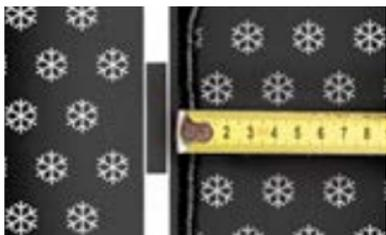
Признаком хорошего, правильного прогрева материала является вытекание битумно-полимерного вяжущего из-под боковой кромки материала от 10 до 25 мм.
