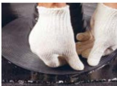
Вдавите юбку в разогретый материал. Следите за равномерным вытеком битумно-полимерного вяжущего из-под юбки уплотнителя. Вытек обеспечит полную герметичность соединения.
