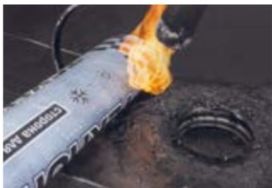
Произведите укладку нижнего слоя (см. п. 5.2.1 «Наплавление нижнего слоя» или п. 5.2.2 «Механическая фиксация нижнего слоя» или п. 5.2.4. «устройство однослойной кровли»). Боковой нахлест полотен должен проходить через ось воронки.
