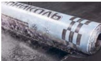
Для качественного наплавления материала на основание необходимо добиться небольшого валика битумно-полимерного вяжущего в месте соприкосновения материала с поверхностью.
