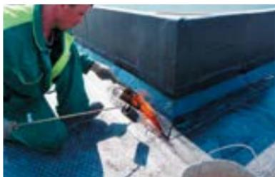
После выполнения вертикальной приклейки, наплавьте материал на переходной бортик и на горизонтальный участок.
