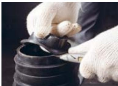
Обрежьте уплотнитель под выбранный диаметр трубы.
