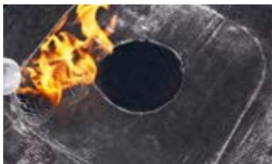
Разогрейте пламенем горелки область слоя усиления, на которую будет установлена воронка.
