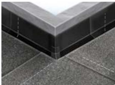
Наплавьте верхний слой из материала Техноэласт ЭКП (см. п. 5.2.3).
