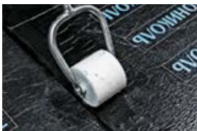
Для улучшения качества приклейки уложенный материал прикатывают тяжелым роликом. Продольные швы дополнительно прикатывают тяжелым ручным.
