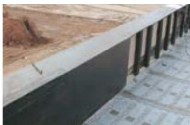
Вертикальные поверхности конструкций, выступающие над кровлей и выполненные из штучных материалов (кирпича, пенобетонных блоков), можно обшить прессованными плоскими хризотилцементными листами или цементно-стружечными плитами марки ЦСП-1 на всю поверхность заведения дополнительного гидроизоляционного слоя.
