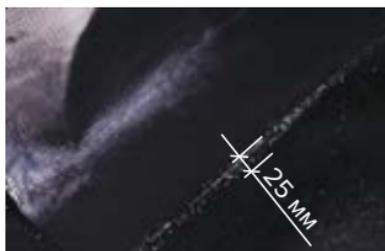
Признаком хорошего, правильного прогрева материала является вытекание битумно-полимерного вяжущего из-под боковой кромки материала от 10 мм до 25 мм
