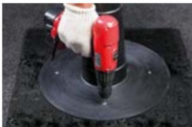
Установите аэратор, вдавите юбку в разогретый материал, закрепите аэратор в несущее основание (см. способ 1).
