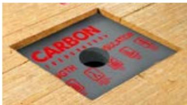
При устройстве кровельного ковра по основанию из сборных стяжек или теплоизоляционных плит местное понижение в местах установки воронки можно добиться за счет уменьшения толщины теплоизоляционного слоя на 20–30 мм на расстоянии 500 мм от центра воронки.
