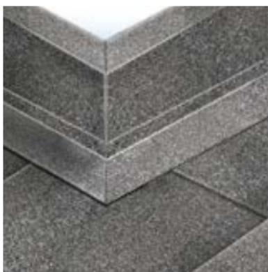
Наплавьте верхний дополнительный слой из материала Техноэласт ЭКП на всю плоскость парапета с другой стороны угла парапета.
