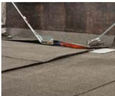
Вставьте сопло шовной горелки под шов и сварите данный нахлест.
