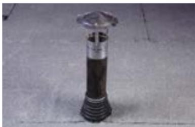
Установите оцинкованный колпак на трубу, и примыкание с трубой будет готово. Диаметр колпака должен быть больше диаметра трубы минимум на 60 мм.
