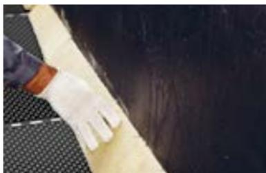
При устройстве кровли методом механической фиксации нижнего слоя, наклонные бортики (ТЕХНОРУФ ГАЛТЕЛЬ) устанавливаются на предварительно разогретый пламенем горелки материал, подведенный к парапету.
