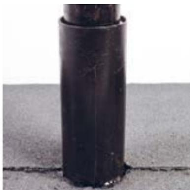
Наплавьте верхний слой из материала Техноэласт ЭКП (см. п. 5.2.3 «Наплавление верхнего слоя»).
