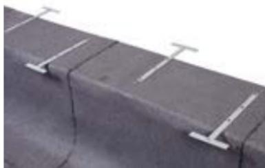
Установите кровельные костыли с каждой из сторон парапета с шагом не более 750 мм.
