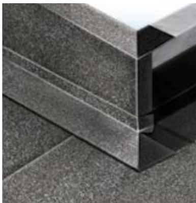
Наплавьте дополнительный верхний слой на всю плоскость парапета с одной стороны угла парапета.
