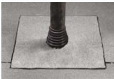
Подготовьте и наплавьте слой усиления. Слой усиления должен перекрывать юбку уплотнителя на 150 мм.
