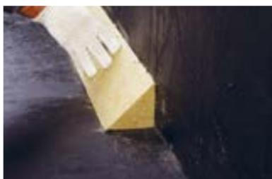
Установите наклонные бортики (ТЕХНОРУФ ГАЛТЕЛЬ) на Мasticу кровельную горячую ТЕХНОНИКОЛЬ № 41 (Эврика) в местах примыкания к парапетам, стенам и другим вертикальным конструкциям.
