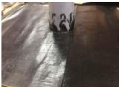
Уложите нижний слой на горизонтальной поверхности (см. п. 5.2.1. «Наплавление нижнего слоя» или п. 5.2.2. «Механическая фиксация нижнего слоя»)
