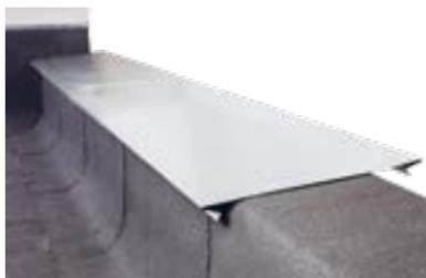
Установите оцинкованный фартук на кровельные костыли. Фартук будет предохранять парапет от воздействия атмосферных осадков и механических повреждений.
