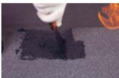
В случаях наплавления по крупнозернистой посыпке (торцевые, боковые нахлесты и т.п.) удалите посыпку из области наплавления:
