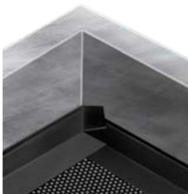
Установите и наплавьте полосы слоя усиления из материала Техноэласт ЭПП.
