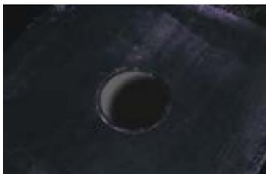
В установленном дополнительном слое усиления прорежьте круглое отверстие по краю водоприемной воронки.
