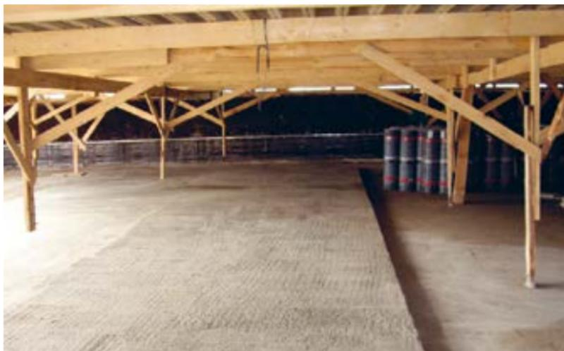
Работы по наплавлению должны производиться в отсутствие осадков. В других случаях необходимо устраивать навесы, а при отрицательных температурах тепляки.
