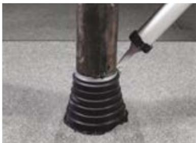
Для герметизации соединения между трубой и уплотнителем нанесите герметизирующую мастику ТЕХНОНИКОЛЬ № 71.
