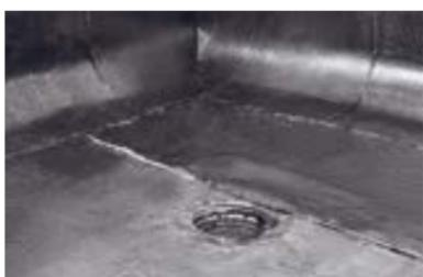
Прорежьте кровельный ковер по отверстию трубы водоприемной воронки.
