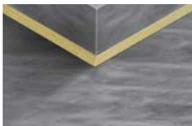
Установите наклонные бортики (ТЕХНОРУФ ГАЛТЕЛЬ) в местах примыкания с парапетом на Мاستику кровельную горячую ТЕХНОНИКОЛЬ № 41 (Эврика).
