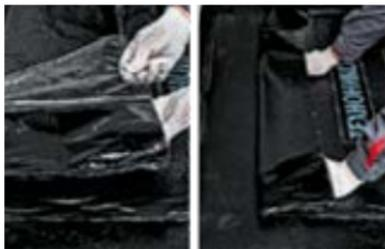
Снимите съемную пленку и наклейте часть материала на основание.
