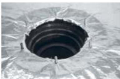
Прорежьте кровельным ножом пароизоляционный слой по внутреннему диаметру воронки.
