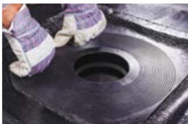
Вдавите чашу воронки (воронка ТЕХНОНИКОЛЬ с обжимным фланцем или надставной элемент с обжимным фланцем в зависимости от выбора устройства воронки) в разогретую область.
