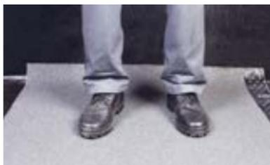
Для того, чтобы рулон не смещался в процессе выравнивания, и для того, чтобы не образовывались волны на рулоне, необходимо, чтобы кровельщик встал на один конец рулона, а другой кровельщик выравнивал рулон, контролируя нахлесты.
