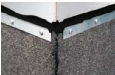
Край краевой рейки крепите на расстоянии не менее 50 мм от угла стены. Во внешнем углу это предотвратит скол стены.
