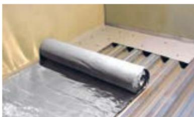
При раскатке рулона вдоль вертикальной конструкции (стены, парапета, вентиляционные шахты и т.п.), уложите материал. Паробарьер вплотную к вертикальной поверхности.
