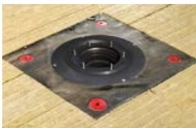
К листу плоского шифера (см. п. 2.5.3.) приварить слой усиления из материала Техноэласт ЭПП можно при помощи фена горячего воздуха.
