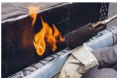
**ВАЖНО!** На вертикальных конструкциях (стены, парапет, вентиляционные шахты и т.п.) запрещается механическая фиксация кровли. Кровельный ковер должен быть полностью приклеен на основание.
