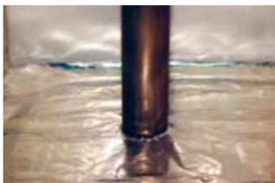
Уложите на основание пароизоляционный слой, обрезав пароизоляционный материал вокруг трубы.
