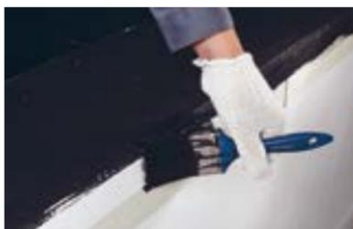
Нанесите праймер на парапет со стороны фасада на 50 мм, для заведения гидроизоляционного материала.
