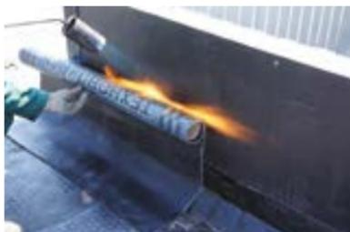
Наплавление производите раскатывая рулон снизу вверх от верхнего края переходного бортика.
