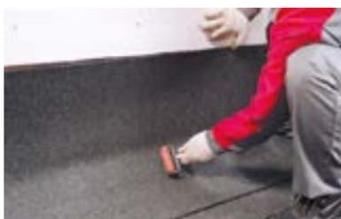
В примыкании к вертикальным поверхностям проверяют, чтобы кровельный ковер был приклеен по всей площади и не повисал.
