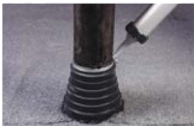
Для герметизации соединения между трубой и уплотнителем нанесите Мasticу герметизирующую ТЕХНОНИКОЛЬ № 71.
