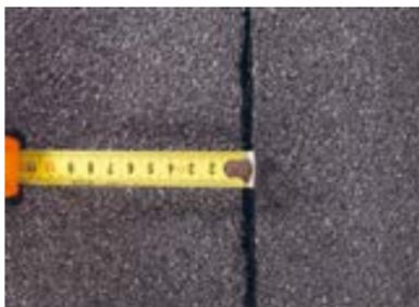
Шов должен быть однородным, ширина полосы вытекания битумной массы из зоны шва, должна быть от 10 мм до 25 мм. По краю рулона в зоне шва не должно быть остатков защитной пленки.
