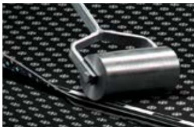
Сразу после сварки, пока не остыл материал, пройдите прикаточным роликом по сваренному шву для полной герметизации нахлеста.
