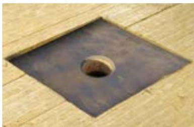
Поверх экструзионного пенополистирола укладывается хризотилцементный плоский лист толщиной 10 мм, огрунтованный праймером с двух сторон.
