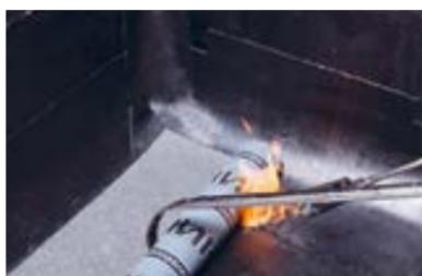
Наплавьте верхний слой из материала Техноэласт ЭКП (см. п. 5.2.3 «Наплавление верхнего слоя»).
