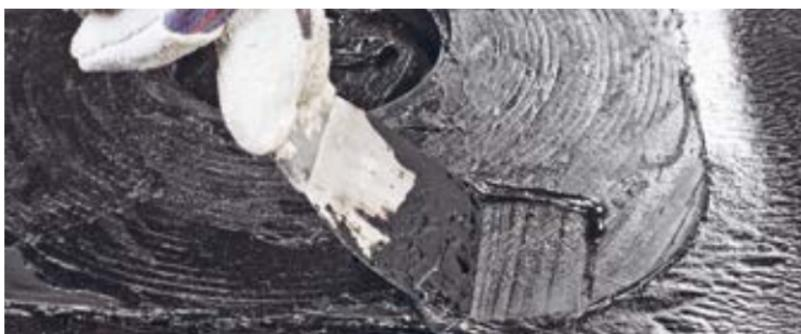
Для создания герметичного соединения необходимо обмазать фланец аэратора битумным вяжущем. Все способы нанесения битумного вяжущего рассмотрены в п. 5.1.3 на примере обмазывания фланца воронки.
