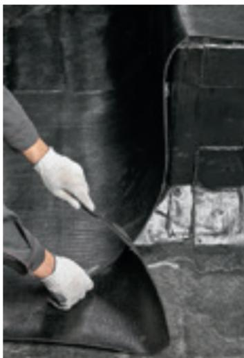
— Примерку первого слоя вертикальной гидроизоляционной мембраны проведите таким образом, чтобы один из нижних углов вертикальной мембраны совпадал с углом горизонтальной мембраны (в нашем случае это правый угол). Обрежьте кровельным ножом лишнюю часть по уровню фундаментной плиты. В месте перехода рулона на бетонную подготовку разрез выполняйте по диагонали к углу рулона.
