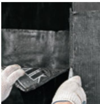
— Отрежьте ненаплавленную часть рулона до уровня фундаментной плиты.
