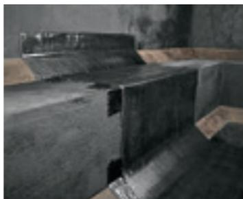
— Наплавьте материал на горизонтальную часть фундаментной плиты и завершите укладку материала, тщательно приплавив нижнюю часть рулона вертикальной гидроизоляционной мембраны к горизонтальной мембране на бетонной подготовке.
