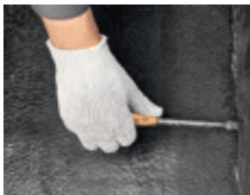
— Качество соединения материалов между собой можно контролировать при помощи, например, шлицевой отвертки с закругленными краями (но не режущим инструментом). Проверка производится после полного остывания материала.
