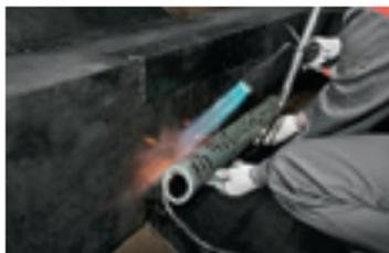
— При наплавлении рулоны укладывают **снизу вверх** (вне зависимости от способа подачи рулона) поэтапно на высоту, определяемую технологическим регламентом монтажа.
