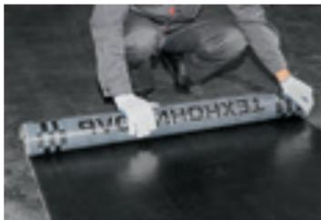
— После этого скатайте материал в рулон с двух сторон в направлении центра (к середине). Намотку лучше производить на металлическую трубу или картонную шпулю.
