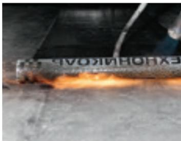
— Наплавление производите, оплавляя нижнюю поверхность рулона пламенем горелки и одновременно подогревая поверхность основания. Нагрев производят плавными движениями горелки, уделяя особое внимание зонам нахлеста, постепенно раскатывая рулон на себя.
