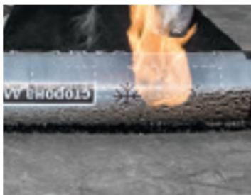
— Небольшой валик битумной массы в месте соприкосновения рулона с основанием свидетельствует о правильном температурном режиме наплавления. Имеющаяся на нижней поверхности материала полиэтиленовая пленка должна быть полностью оплавлена. При этом будет происходить деформация индикаторного рисунка.
