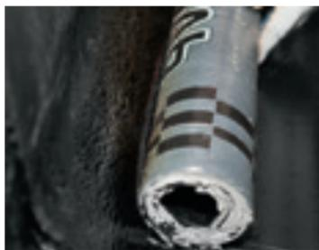
— Небольшой валик битумной массы в месте соприкосновения рулона с основанием свидетельствует о правильном температурном режиме наплавления.
