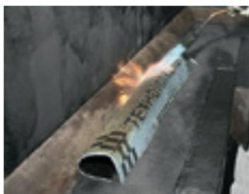
— Наплавьте слой усиления в месте перехода «фундаментная плита — вертикальные ограждающие конструкции». Наплавление производится аналогично наплавлению слоя усиления в месте перехода «бетонная подготовка — фундаментная плита» (см. п. 3.1).
