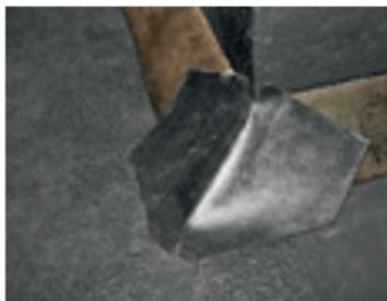
— Выполните элемент усиления внешнего угла в месте перехода с горизонтальной поверхности фундаментной плиты на вертикальную поверхность ограждающей конструкции. Сначала разрежьте и примерьте заготовку по месту.
