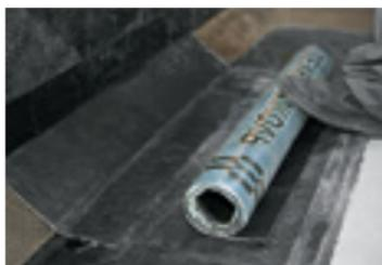
— Скатайте подготовленную заготовку материала в рулон. Намотку рулона лучше производить на трубу или картонную шпулю при ручной подаче рулона либо на ролик подачи при механической подаче рулона.
