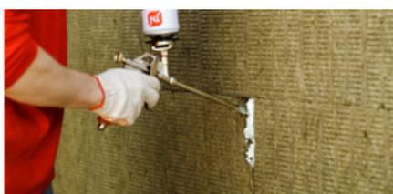
**9.** Отверстия, швы и зазоры размером менее 5 мм заполните клей-пенной. Более 5 мм — фрагментами каменной ваты.
