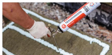
**6.** Нанесите клей-пену полосами шириной 20-30 мм. Перед приклеиванием плиты подождите 3-5 минут до полного расширения клей-пены.
