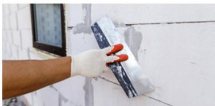
**1.** Подготовьте стены перед утеплением. Удалите осыпающуюся штукатурку и выступающие части (гвозди, арматуру). Выровняйте поверхность штукатурным составом. Перепад на 1 этаж не должен превышать 5 мм.
