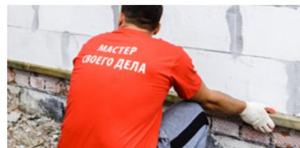
**3.** Установите по уровню стартовый фиксирующий профиль для временной опоры первого ряда плит утеплителя.
