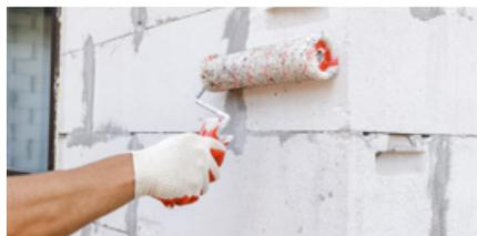
**2.** Огрунтуйте поверхность для обеспыливания и повышения прочности сцепления с основанием.
