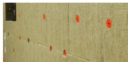
**8.** Через 2 часа дополнительно зафиксируйте плиты механическим креплением из расчета не менее 5-8 дюбелей на 1 квадратный метр.
