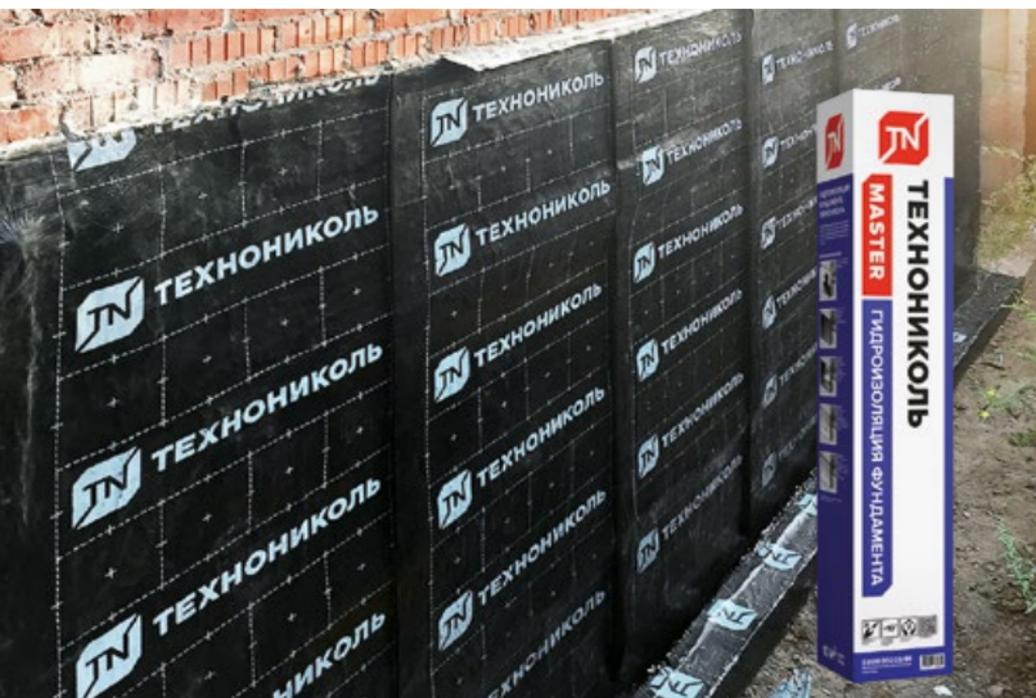
**Гидроизоляция фундамента ТЕХНОНИКОЛЬ** – рулонный самоклеящийся гидроизоляционный материал, разработанный специально для частного домостроения. При низком уровне грунтовых вод материал укладывается в один слой, при высоком (глубина залегания грунтовых вод 2 м и меньше) – в два слоя. Применение самоклеящейся технологии существенно упрощает монтаж материала. Скорость монтажа в разы выше, чем у наплавляемых материалов.
